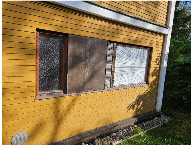
Kuva 14. Julkisivussa on pellityksiä ulkoseinän betonirakenteisten ulokkeiden päällä, (kuvan alaosa) sekä ikkunapellityksenä. Kuva maastokäynniltä 11.9.2025 Immo Kuha / Ramboll.
