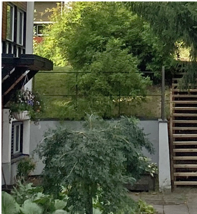
Paikalla valetut tukimuurit sopivat alueen pelkistettyyn ilmeeseen. Paikalla valetulla muurilla voidaan tukea suuriakin maamassoja.
