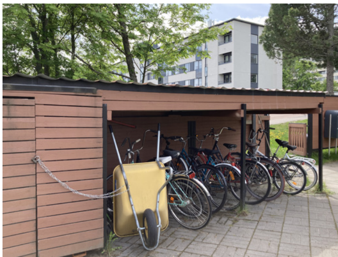
Alkuperäinen varastokatos on matalahko.
