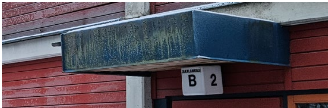
Kuva 23. Esimerkki talotyyppin 2 sisäänkäyntikatoksesta. Alapinnan väritys on ulkoseinän paneelin värityksen mukainen. Katoksen pellitys ulottuu myös katoksen sivulle. Kuva maastokäynniltä 5.12.2024 Immo Kuha / Ramboll
