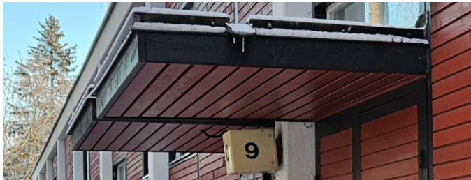
Kuva 22. Esimerkki tyypin 1 rakennuksen sisäänkäyntikatoksesta. Alapinnan väritys on ulkoseinän paneelin ja reunalaudoitus seinärungon väriytyksen mukainen. Katoksessa on käytetty toivottua kevytilmeistä pellitystapaa. Kuva maastokäynniltä 5.12.2024 Immo Kuha / Ramboll
